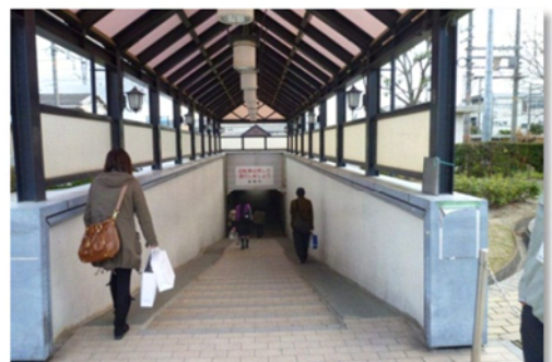
南北連絡通路（西阿知駅南側）
