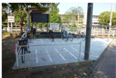
新設した駐輪場(球場前駅)
