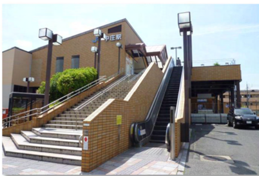
エスカレーター・階段のみの 自由通路（中庄駅北口）
