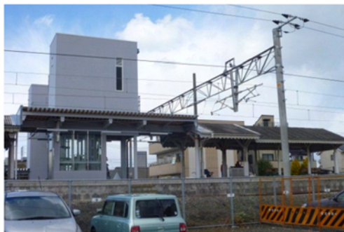
駅南側から直接利用できない（西阿知駅南側）
