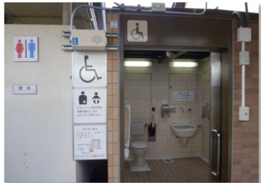
新設された障がい者対応トイレ（西阿知駅）
