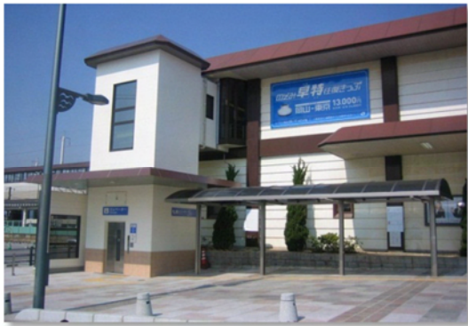
新設された自由通路エレベーター（新倉敷駅南口）
