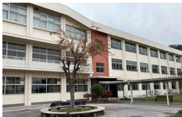
外部改修後（令和6年12月）
