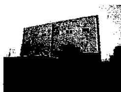
福田東排水機場
