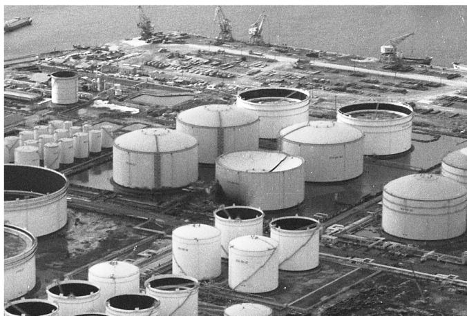
写真2 事故現場全景
