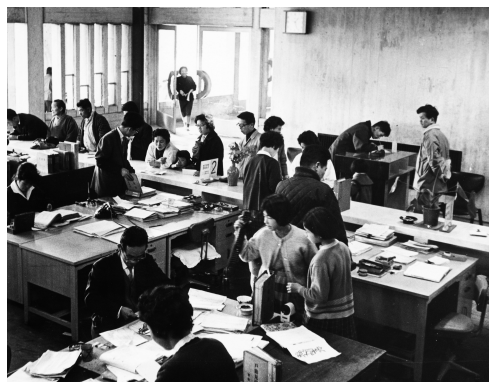
写真3 旧倉敷市役所庁舎内の様子 (昭和36年)
