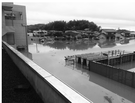
真備支所から見た浸水の様子（平成30年7月8日 午前7時39分、松本直樹氏撮影）
