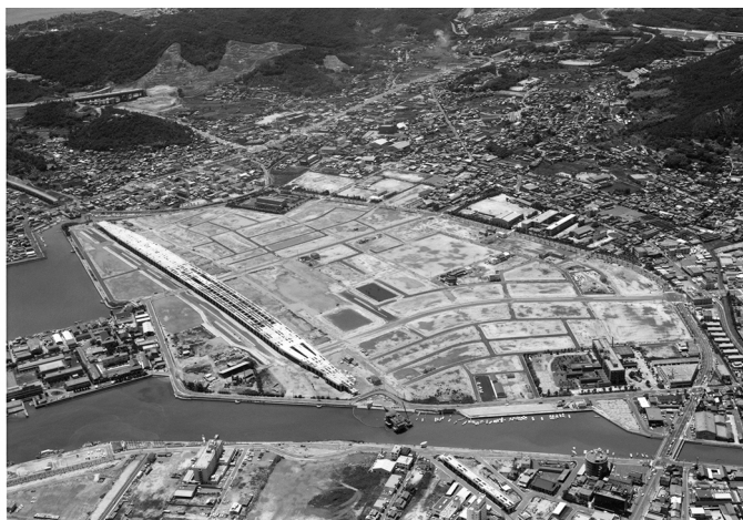
写真2 児島駅前土地区画整理の進展状況（東方上空より）
