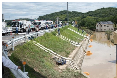
国土交通省の緊急災害対策派遣隊（TEC-FORCE）による排水作業（真備町川辺）
