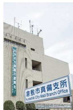
倉敷市真備支所
