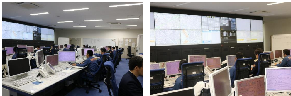
消防指令管制室
