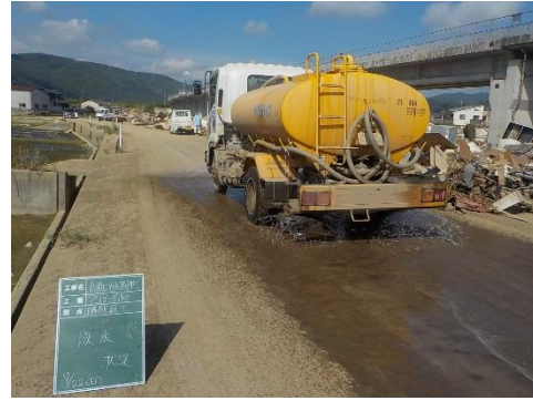
散水車による路面散水
