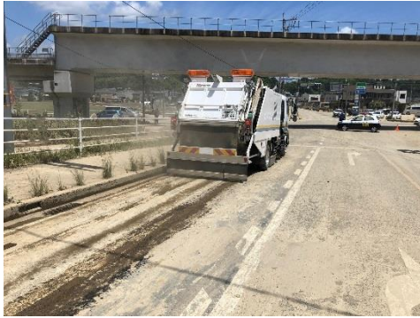
国土交通省の緊急災害対策派遣隊 (TEC-FORCE) による道路啓開
