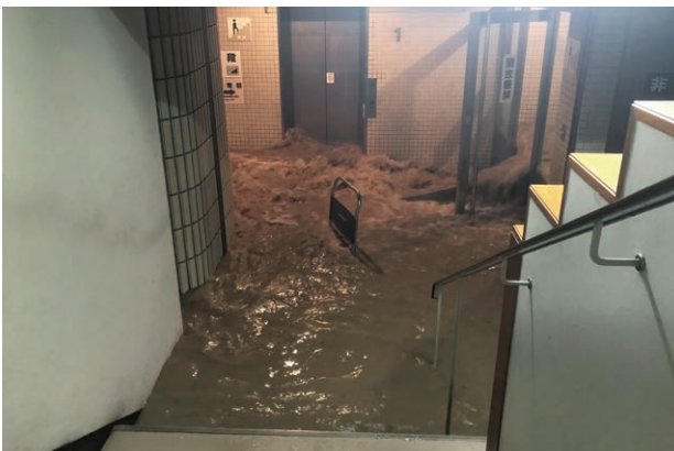
市真備支所の1階へ水が流れ込み2階近くまで浸水=7月7日4時ごろ
