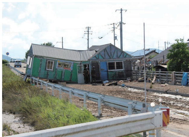
水に流されて、道路をふさぐ建物=真備町有井
