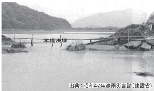
昭和47年7月豪雨 小田川堤防の決壊状況 (倉敷市真備町箭田)
