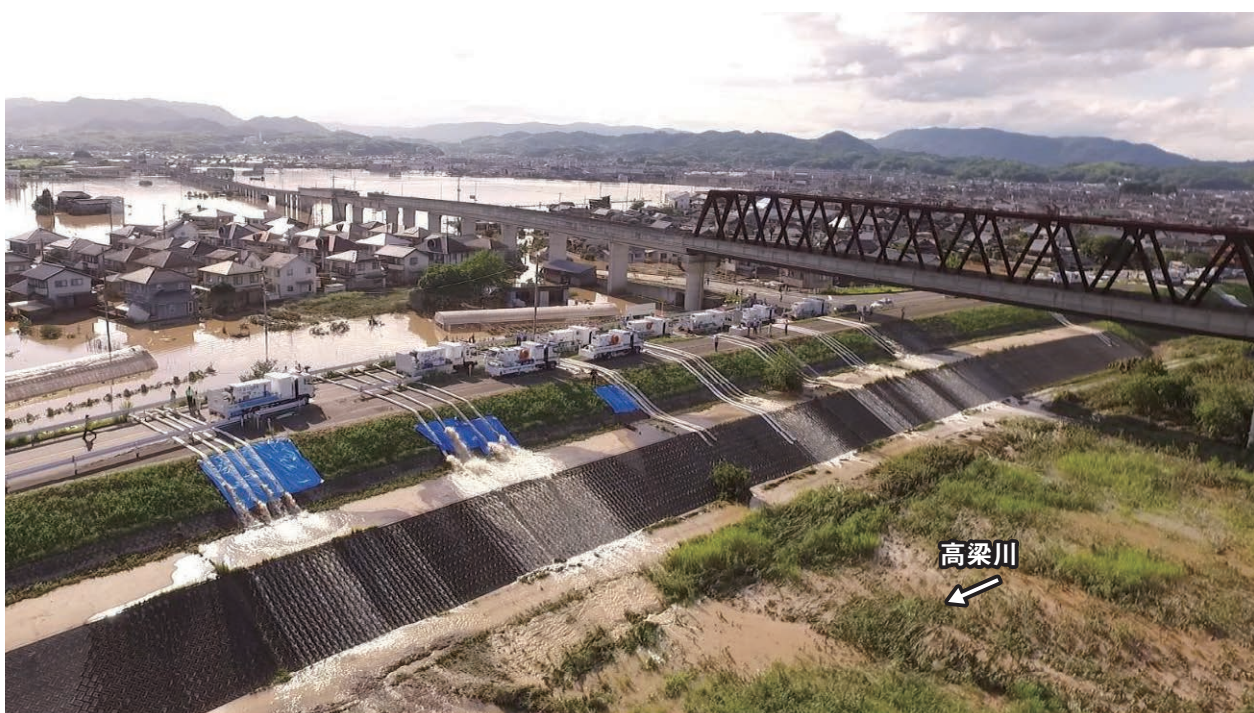
国土交通省の緊急災害対策派遣隊(TEC-FORCE)による排水作業=7月8日、真備町川辺
