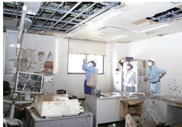
天井まで浸水した真備浄化センター内部の様子
