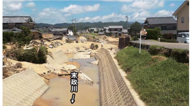
河川の決壊により落下した橋や損壊した道路(真備町有井)
