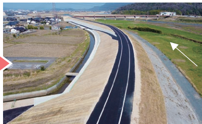
天端幅を約7mに拡幅した小田川堤防= 令和4年3月
