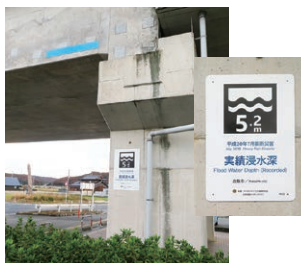
実績浸水深標識
