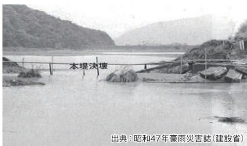
昭和47年7月豪雨 小田川堤防の決壊状況 (倉敷市真備町箭田)
