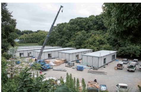
8月6日に着工、9月16日に入居開始した二万仮設団地の建設状況＝8月20日
