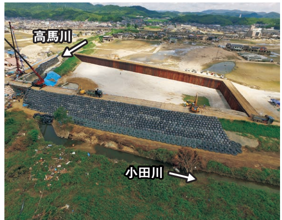
小田川左岸(箭田地区)の緊急復旧工事が完了=7月21日
