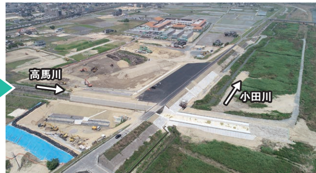
小田川決壊箇所：令和元年6月12日に本復旧完了 高馬川決壊箇所：令和元年6月28日に改良復旧完了
