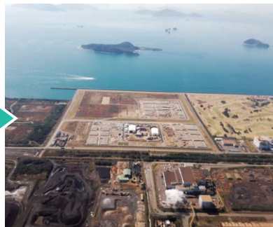
水島に開設した二次仮置場(保管・中間処理)
