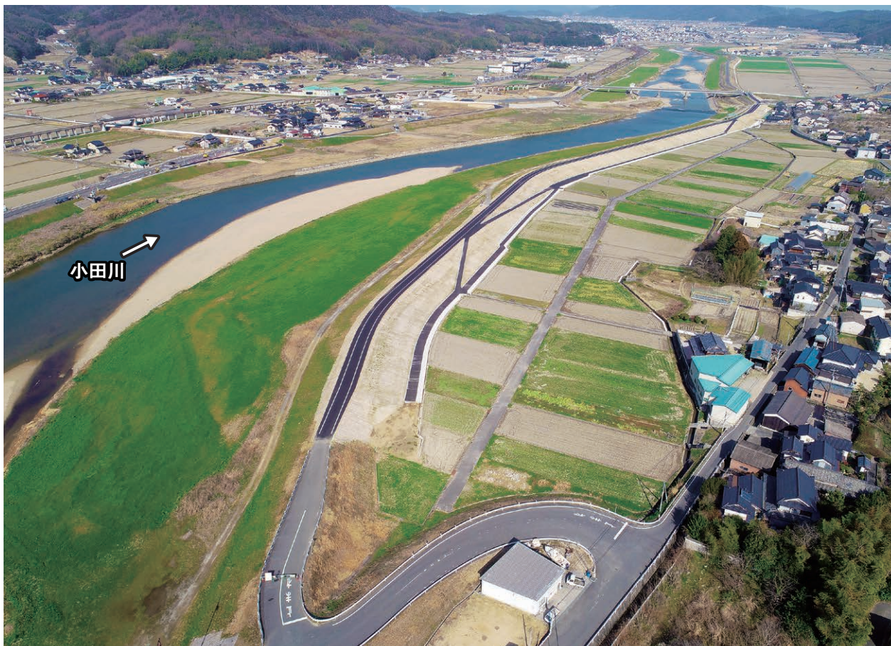
小田川の堤防道路の幅を7mに拡幅する工事が概成＝令和4年3月、真備町服部（八高橋上流右岸）
