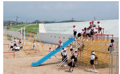
改良復旧工事が終了した堤防を背に遊ぶ子どもたち＝令和5年6月、箭田小学校
