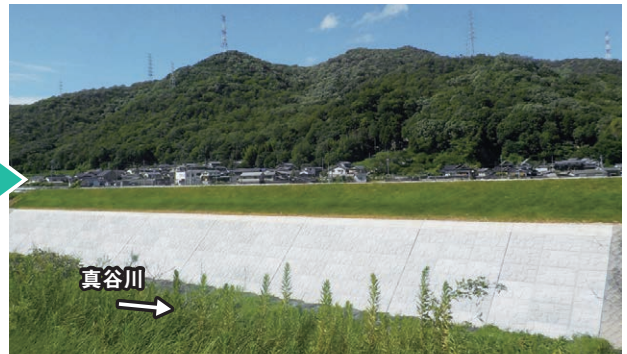
令和元年6月28日に改良復旧完了
