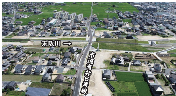
被災前よりも道路を拡幅して復旧した市道有井6号線(真備町有井)
