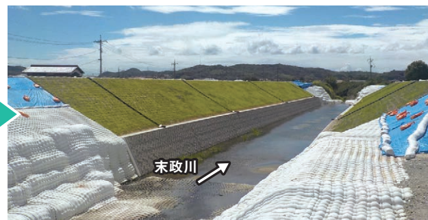
令和元年9月6日に改良復旧完了
