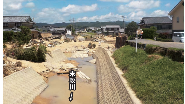
河川の決壊により落下した橋や損壊した道路(真備町有井)
