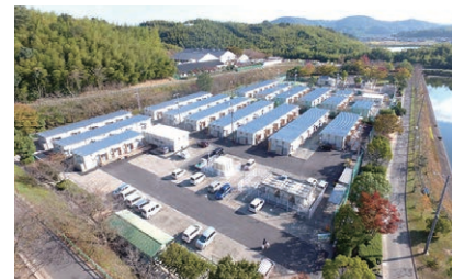
3 真備総仮設団地<プレハブ造>
