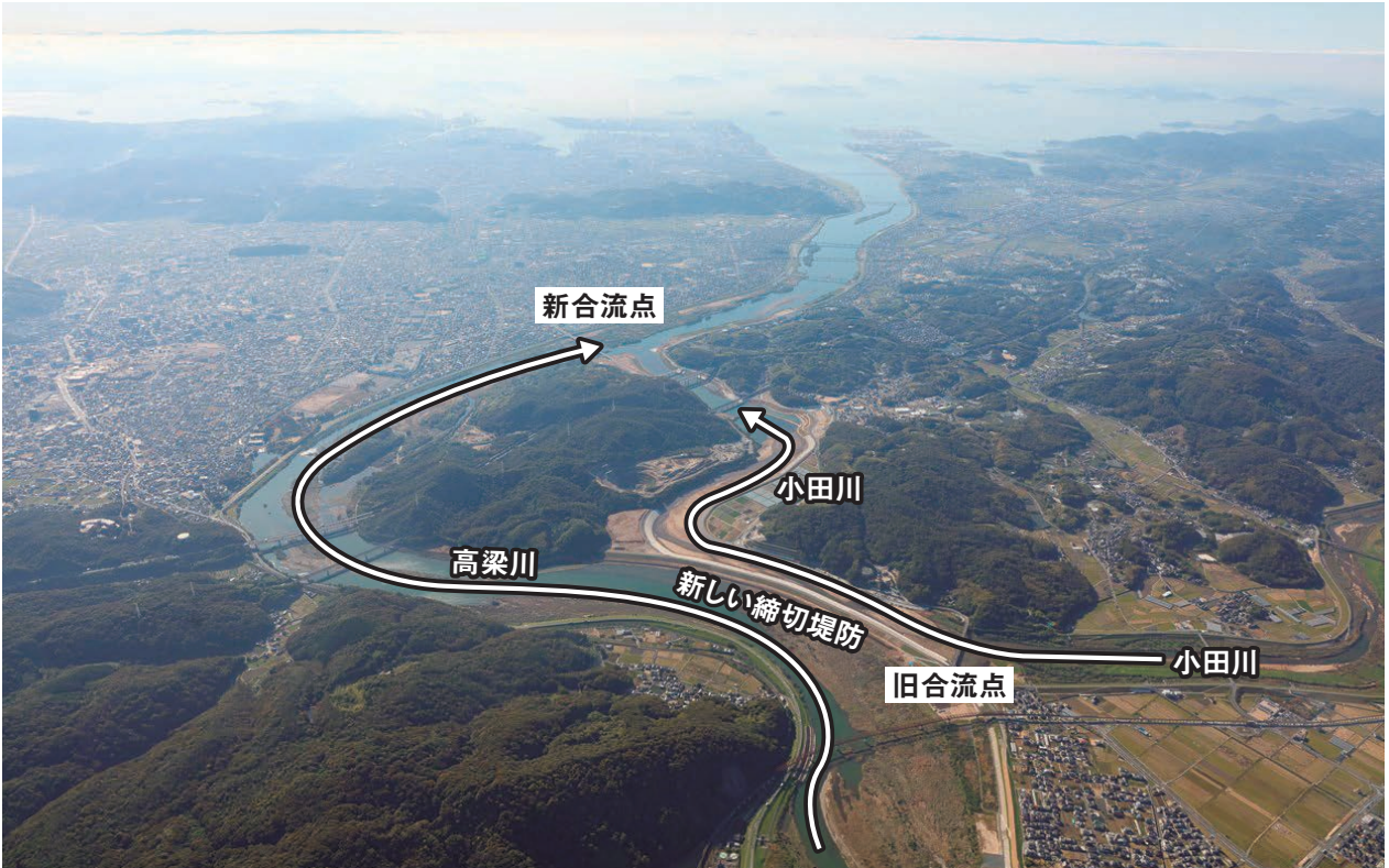
令和6年3月末に完成した小田川合流点付替え事業＝令和6年11月、小田川と高梁川の旧合流点から下流を望む
