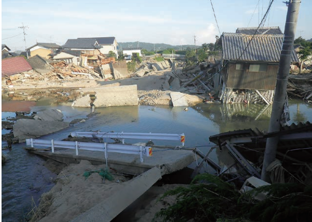
住宅地の被害状況(真備町有井)
