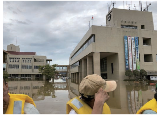
救助ボートから見る浸水した市真備支所
