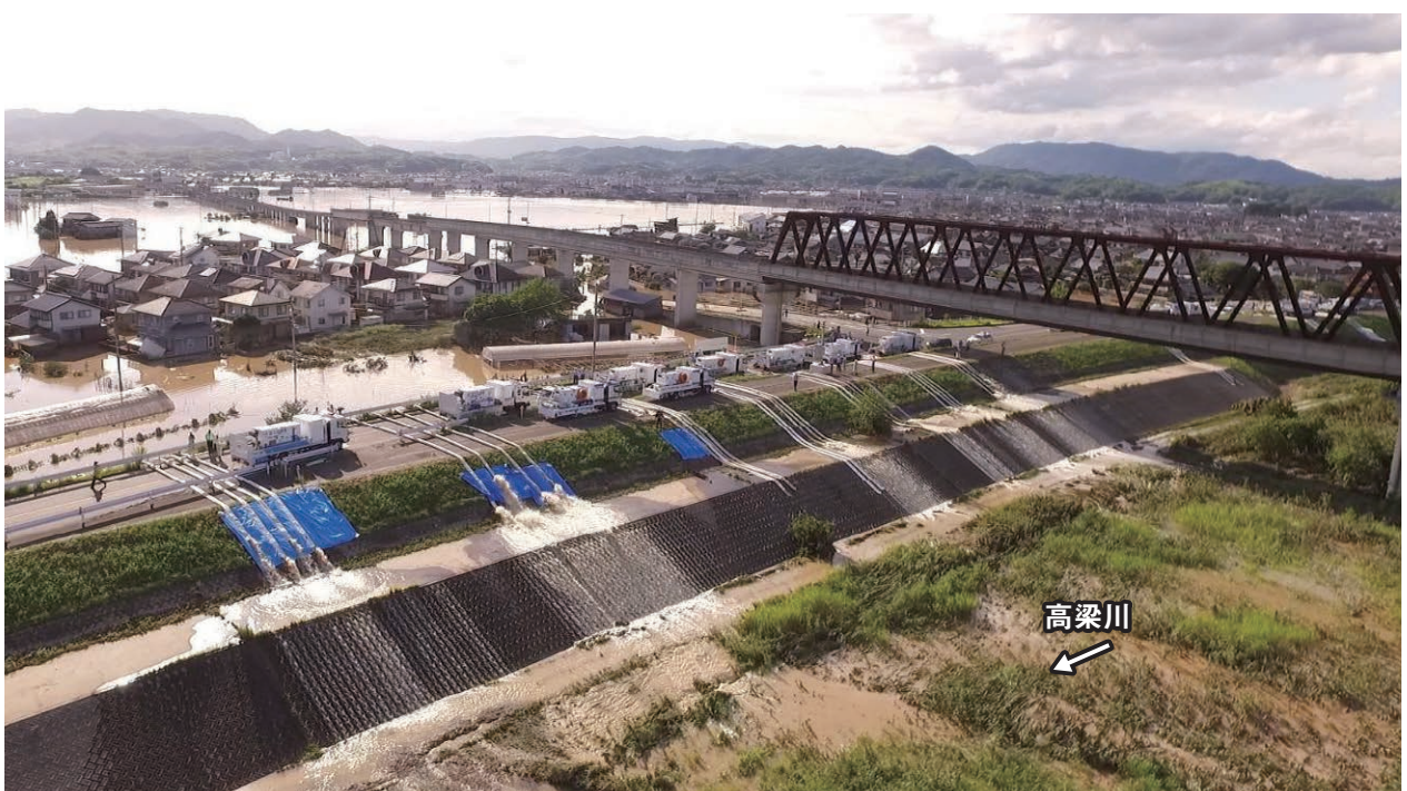
国土交通省の緊急災害対策派遣隊(TEC-FORCE)による排水作業=7月8日、真備町川辺
