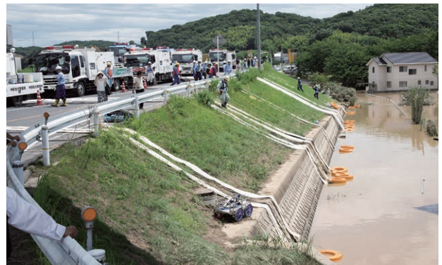
TEC-FORCEによる排水作業=7月8日、真備町川辺
