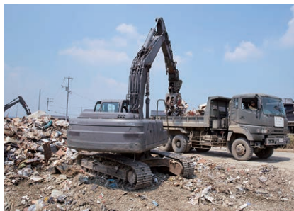
国道486号沿いに積み上げられた災害廃棄物を撤去する自衛隊=7月19日
