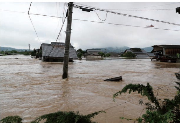
末政川の堤防が決壊した付近。市街地を流れる濁流=7月7日15時36分
