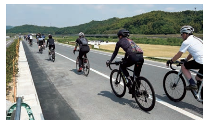
拡幅した小田川の堤防道路はサイクリングロードとしても使われている
