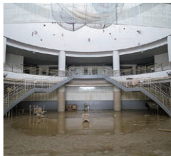
浸水深は約3.5m（1階天井超）に達した
