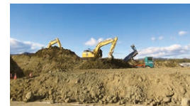
小田川の河道掘削土を有効利用し、堤防の高さまで盛土=令和4年2月
