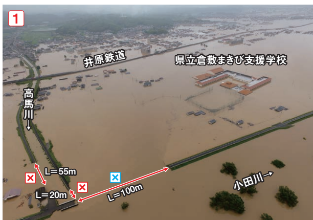
決壊した小田川と高馬川の堤防=7月7日、真備町箭田
