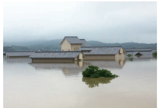
水没した真備浄化センター
