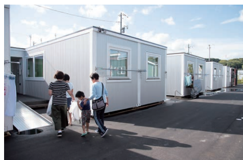
8月3日に着工、9月8日に入居開始したコンテナハウス型の柳井原仮設団地への入居＝9月22日
