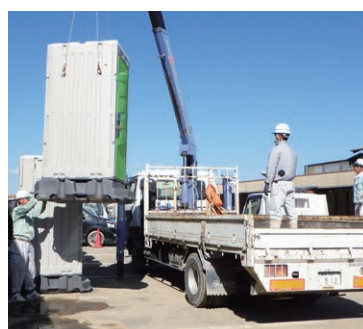
仮設トイレの設置状況
