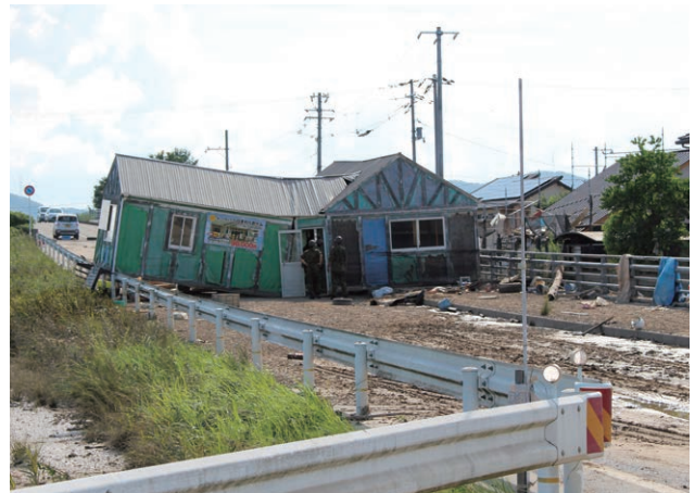
水に流されて、道路をふさぐ建物=真備町有井
