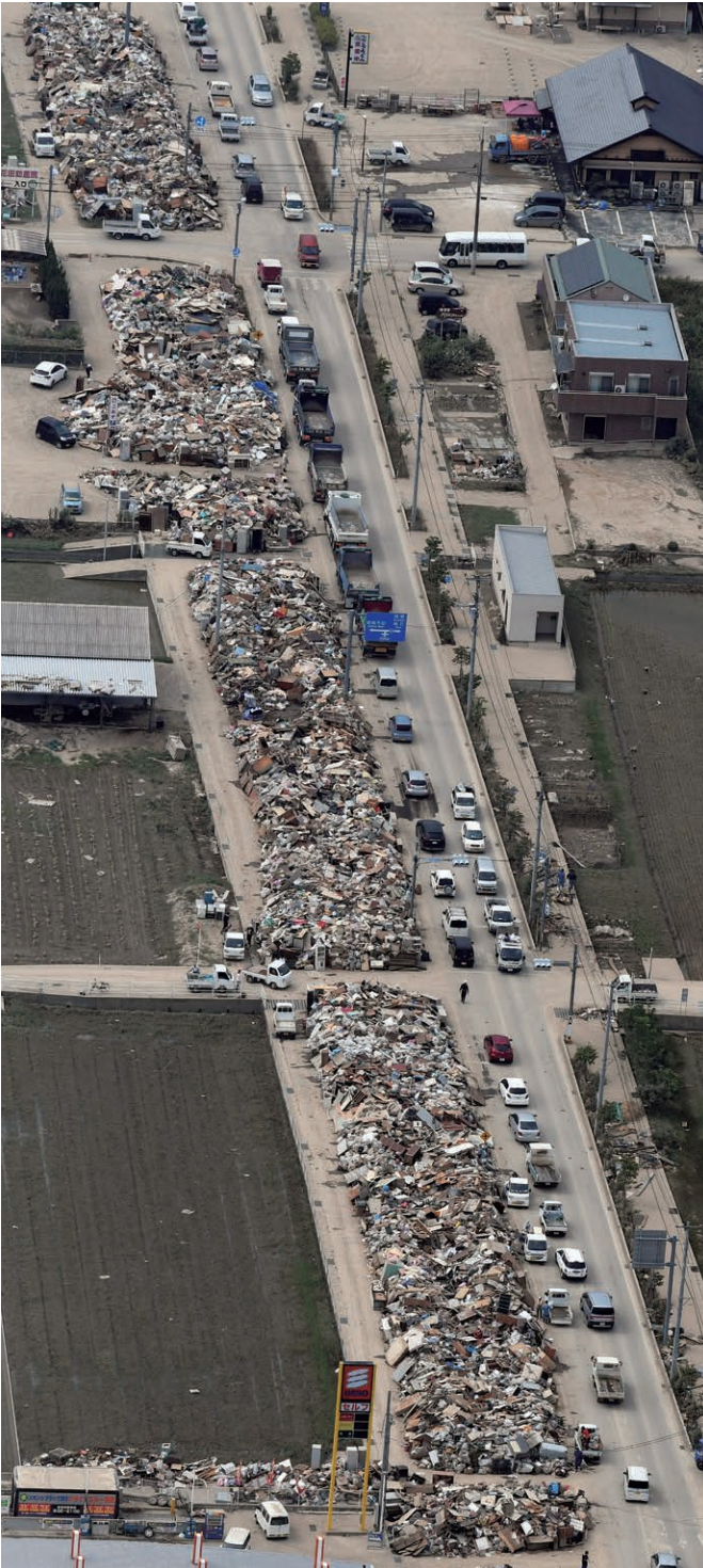
災害廃棄物が山積みされた道路に車列が続く真備町中心部=7月12日、真備町川辺
