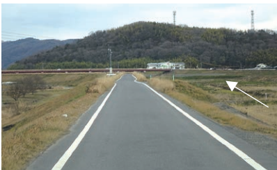
工事着手前の小田川堤防。天端幅は約5m =平成31年2月、二万橋上流左岸
