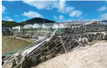
倒壊したハウス
