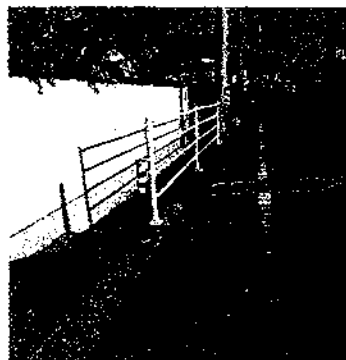
長尾 転落防止柵、ポ ールが設置されました (9/13)
